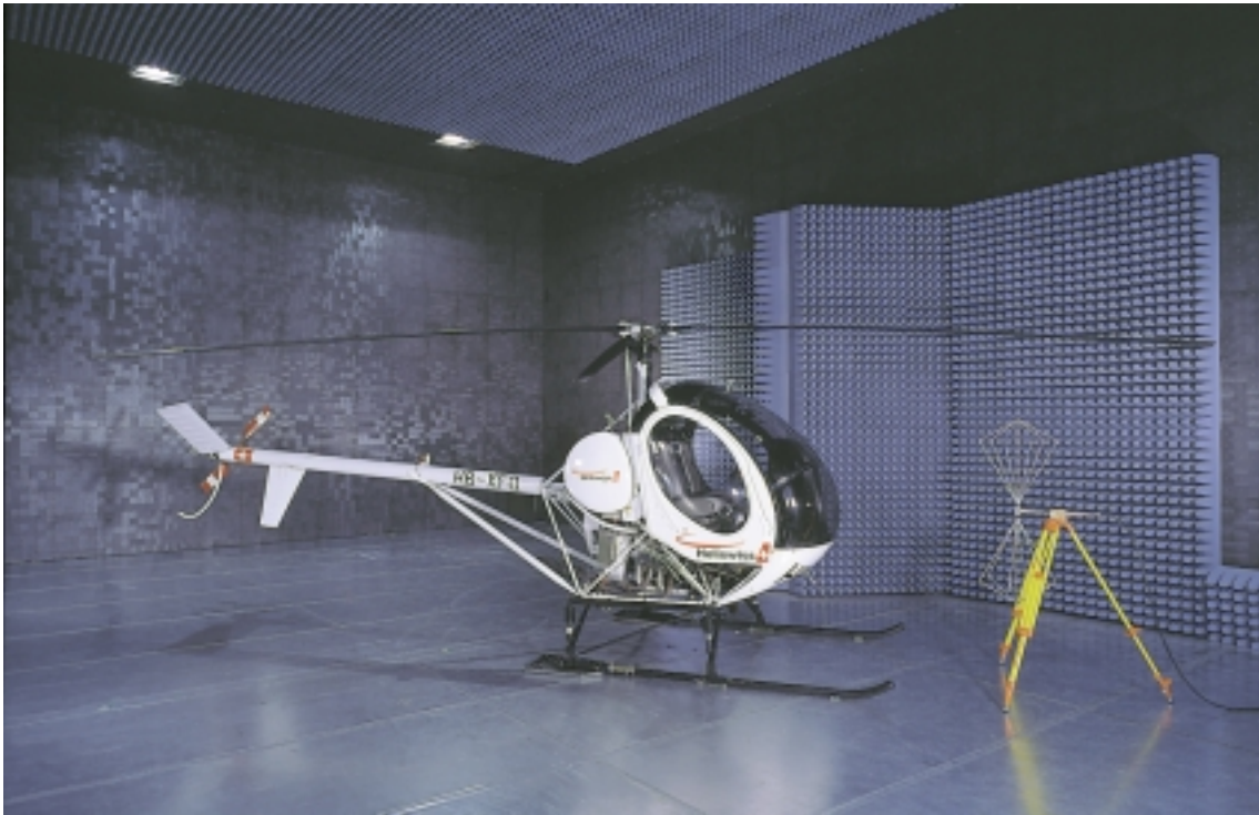
Messungen in einer Ferrithalle von 15,5x10x7 m
